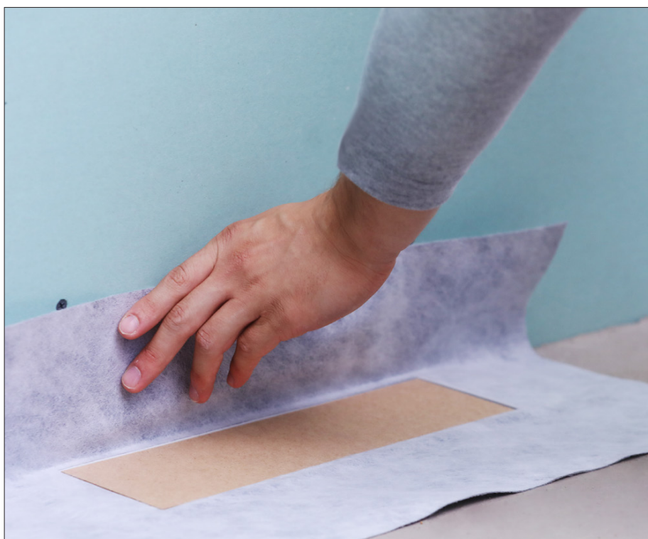
Elastyczny mankiet uszczelniający DallFlex do połączenia z uszczelnieniem zespolonym i wstęgowym zg. z DIN 18534
